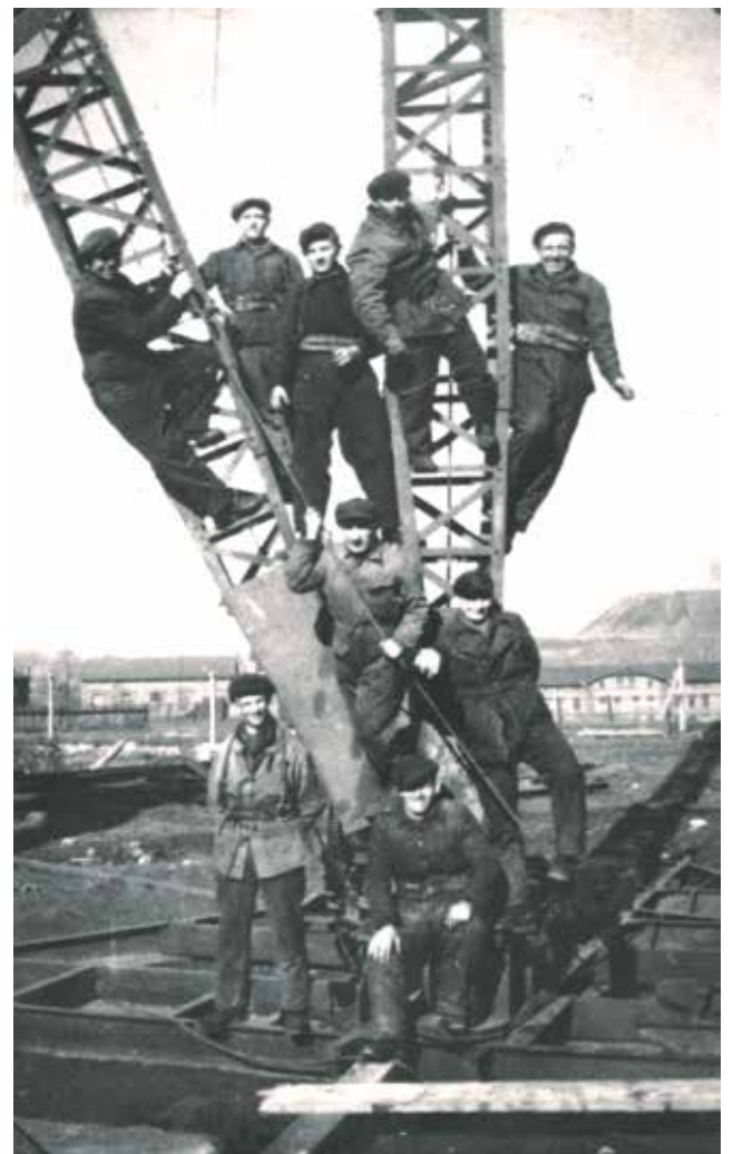
» Brygada oddziału konstrukcyjnego przy demontażu Szybów Siostrzanych na Sobiecinie, 1948 rok (Fot. Kronika Dolnośląskich Zakładów Naprawczych Przemysłu Węglowego w Wałbrzychu)
