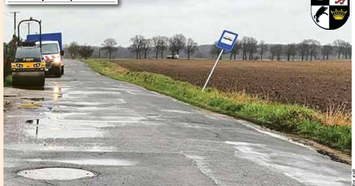
» Ubytki w drogach uzupełniane są w Świdnicy na bieżąco
