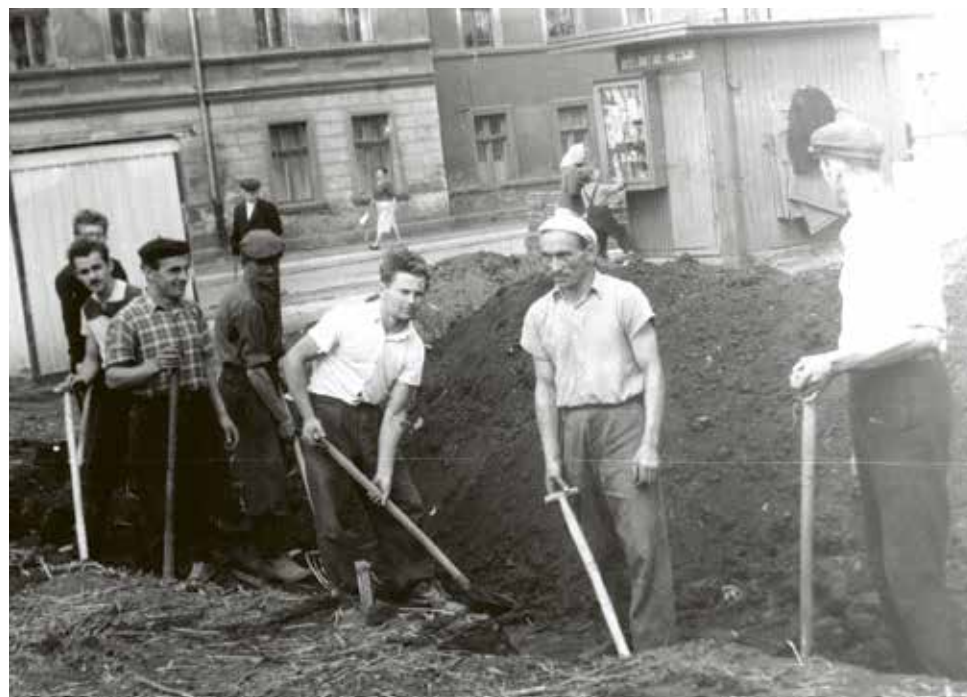
» Czyn społeczny pracowników zakładu przy ul. Wrocławskiej, lata 50./60. (Fot. Kronika Dolnośląskich Zakładów Naprawczych Przemysłu Węglowego)
